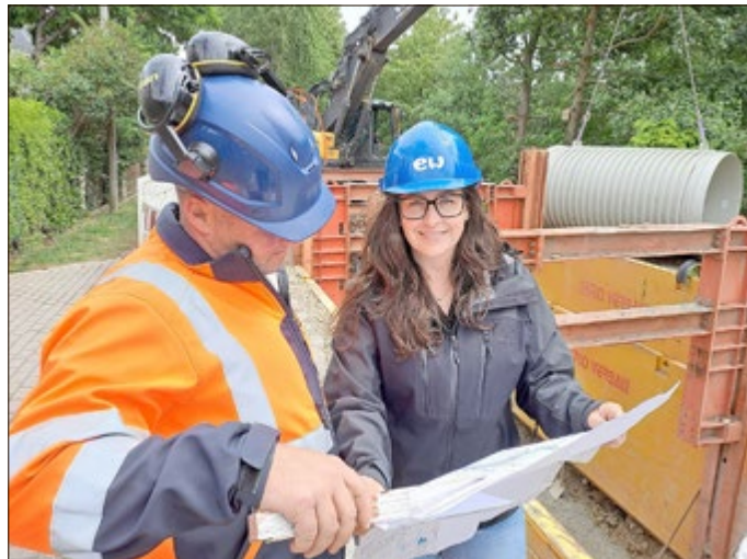
Koordiniert die Kanalbauarbeiten für die Eichsfeldwerke: Ingenieurin Melissa Nolte im Gespräch mit dem Polier der Firma Universalbau, Tommy Schnitter
