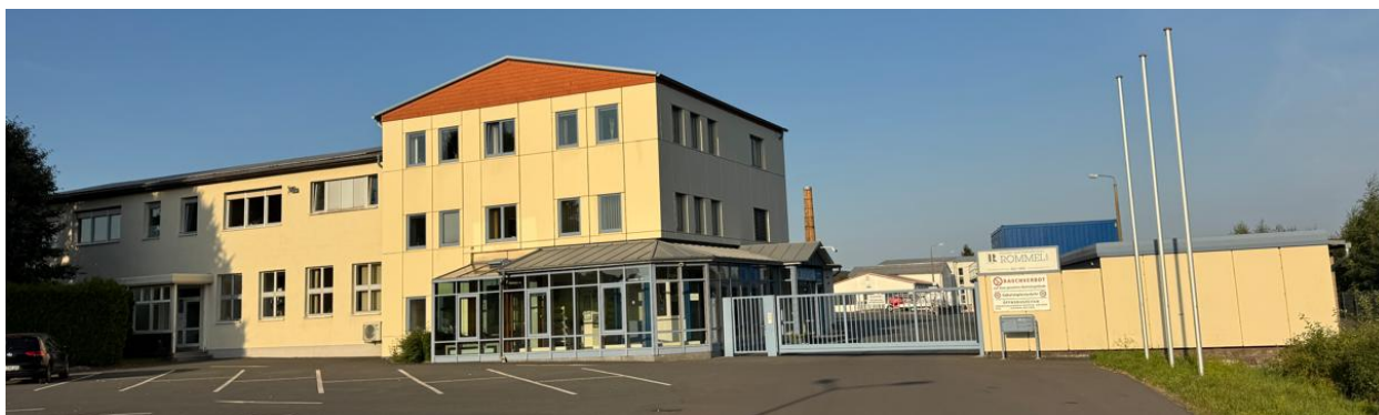
Verwaltungsgebäude der Fensterbaufirma ROMMEL, nord-östlich zum Bauvorhaben gelegen.
