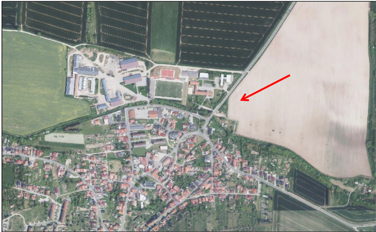
Abb. 1: Übersicht über das Baufeld (Quelle: Geoproxy Thüringen)
