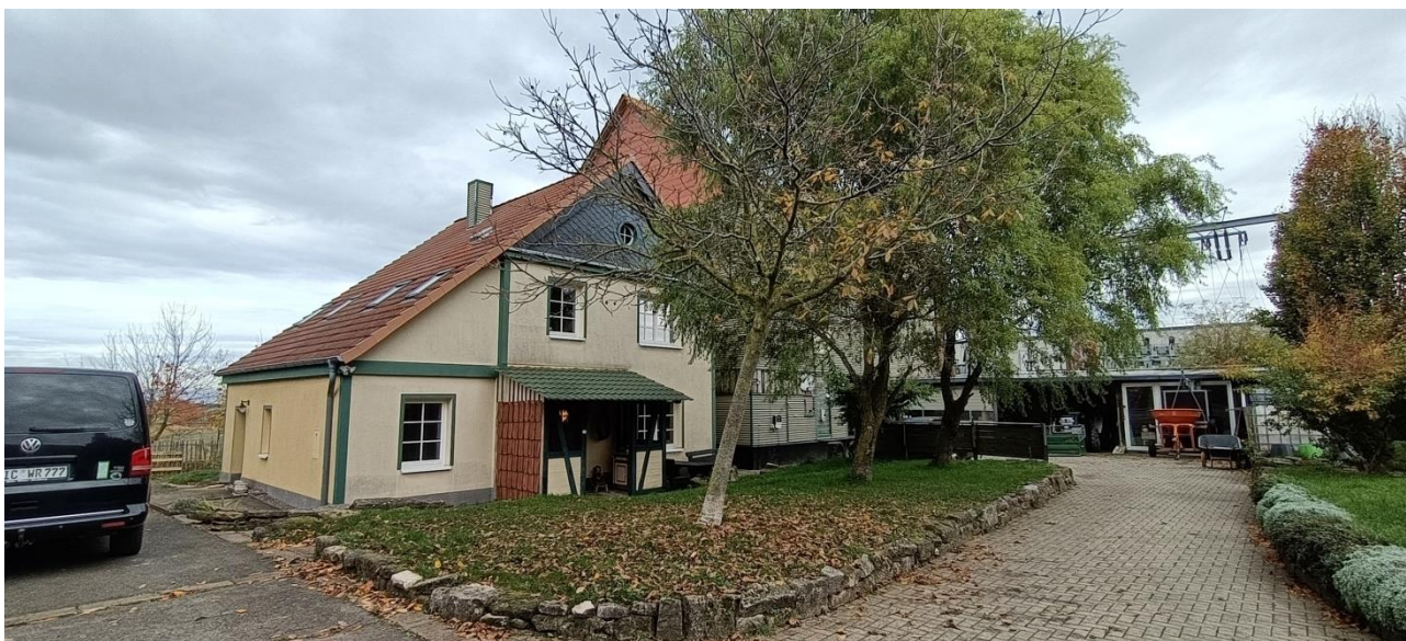
Wohngebäude und Gebäude der ehemaligen Schaltstation
